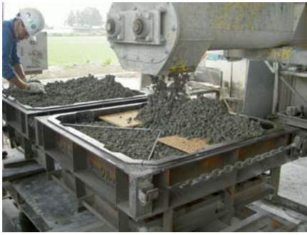
図8 ポーラスコンクリート打設状況
