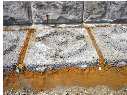
図12 試験施工 盛り土と敷設状況(平成18年8月)
