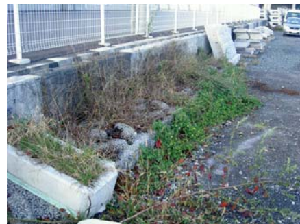
図14 施工後3ヶ月の状況(平成18年11月)
